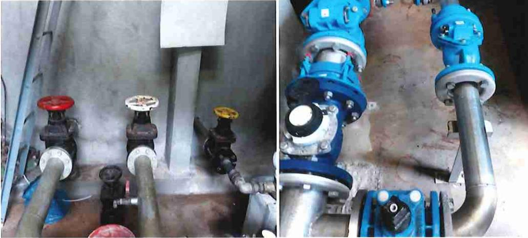
Photo de gauche : en jaune vanne d'arrivée des Captages de la Fousse, en blanc vanne de distribution, en rouge réserve incendie Escalier permettant d'accéder au réservoir et à son flotteur automatique récent. Photo de droite jonction avec l'arrivée du Carteyral par bypass en vert avec deux clapets antiretour (système refoulement / distribution moins cher) et le compteur. Un radiateur vraisemblablement destiné à maintenir le local hors gel ..
